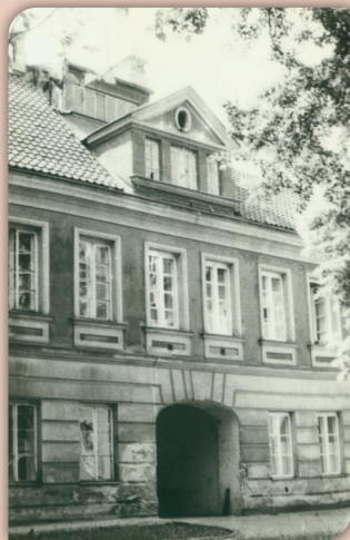
Dom przy ul. Kościelnej 10 na Nowym Mieście w Warszawie
